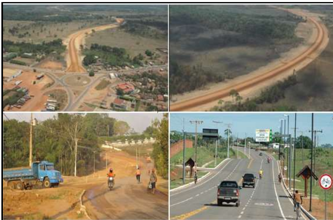
Figura 41 – Obras do Anel Viário da Via Verde e Requalificação da Estrada do Calafate.
