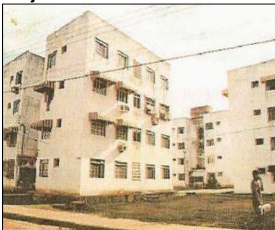
Figura 26 – Apartamentos do Conjunto Manoel Julião
