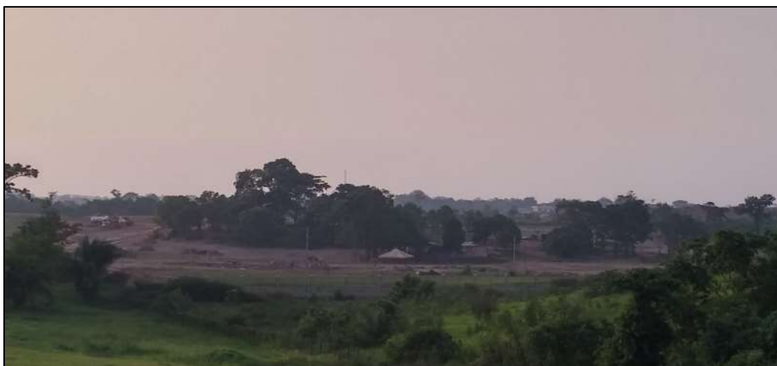
Figura 66 – Canteiro de obras do Ecoville Residence.
