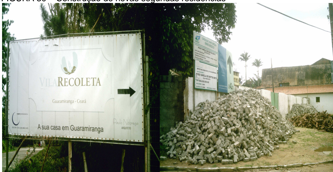
FIGURA 30 – Construção de novas segundas residências
