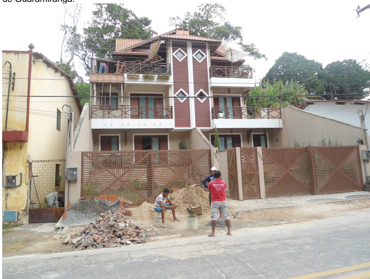
FIGURA 25 – Segunda residência sofrendo reparos por trabalhadores residentes no Centro de Guaramiranga.
