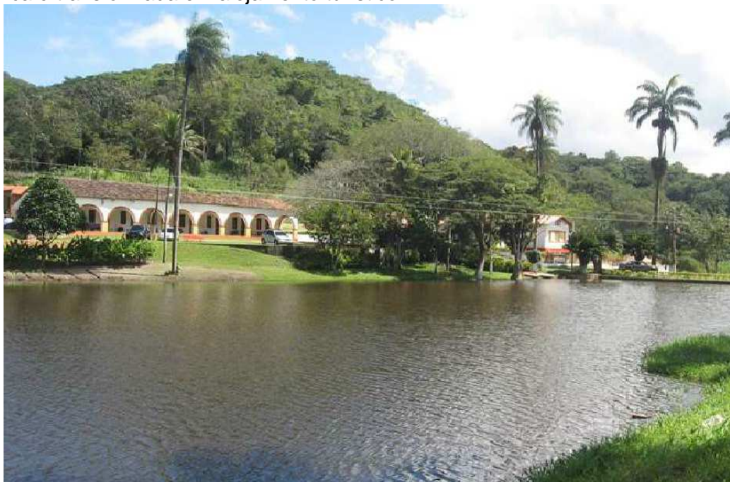
FIGURA 15 - Pousada Logradouro em Guaramiranga, antes fazenda produtora de café transformada em alojamento turístico.
