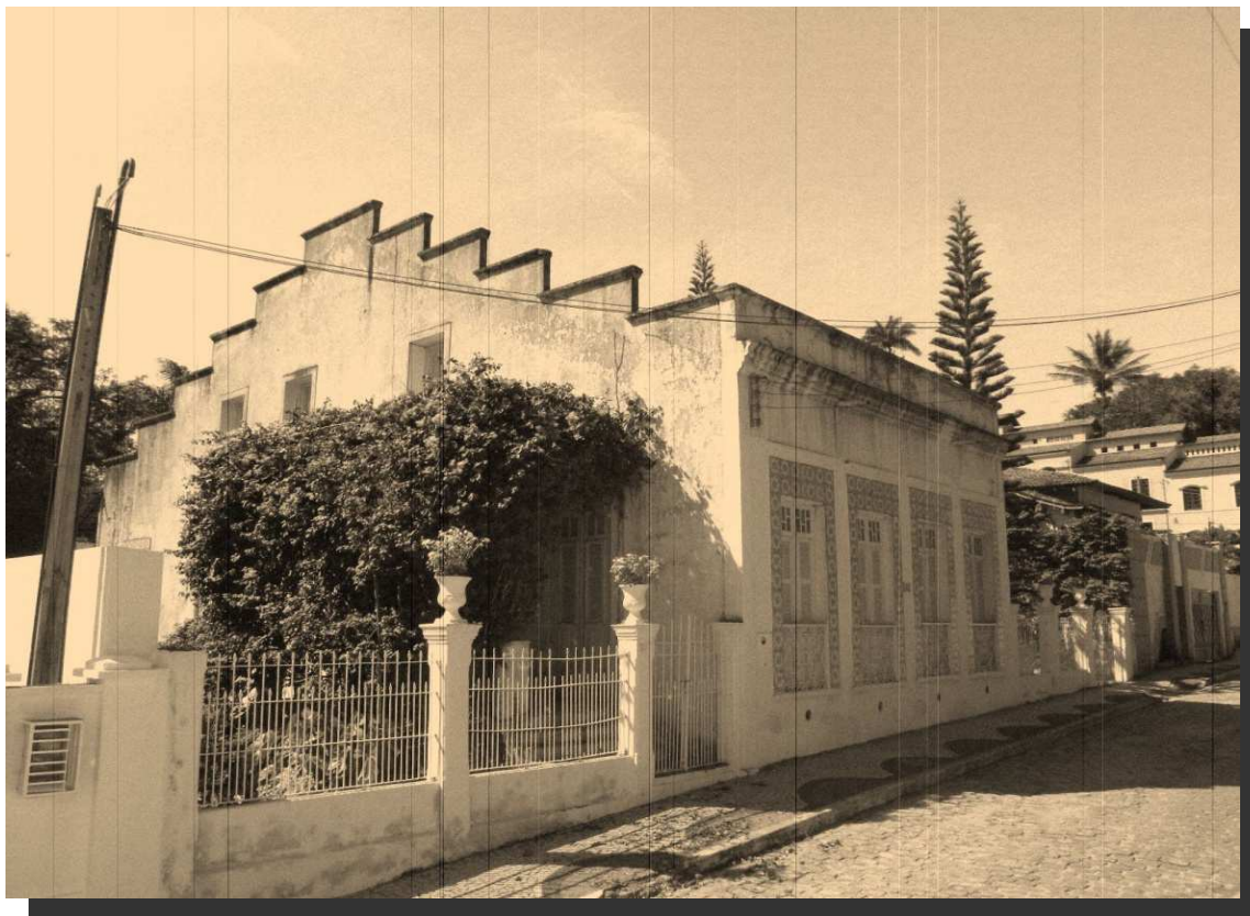
FIGURA 11 – Casarão antigo, datado de 1925 no centro de Guaramiranga.
