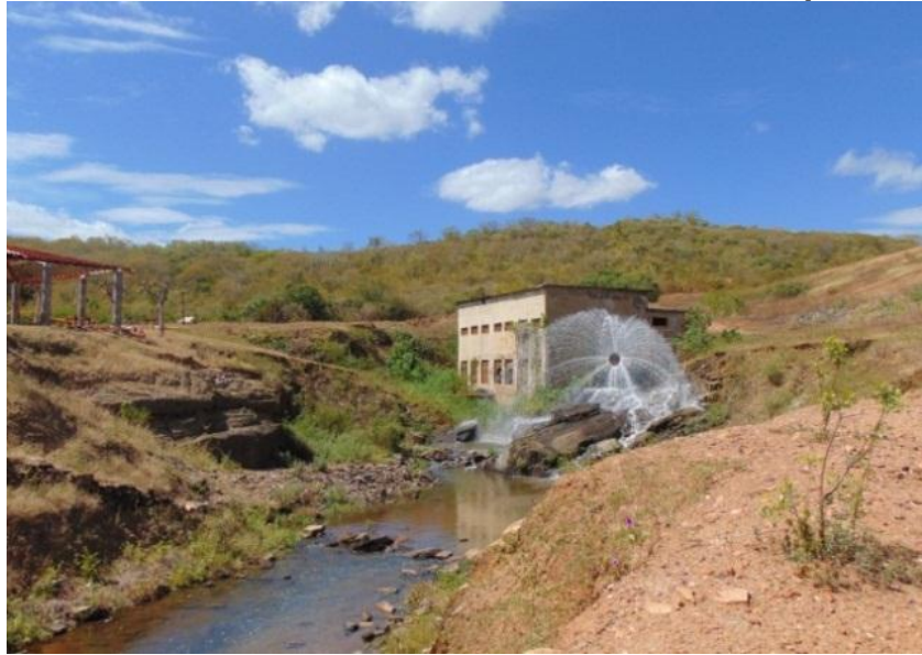
Figura 12 - Válvula do reservatório Caxitoré no município de Umirim
