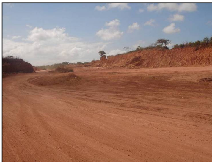
FIGURA 46 – Extração de saibro nos limites entre Fortaleza e Eusébio, dos argissolos vermelho-amarelos.
