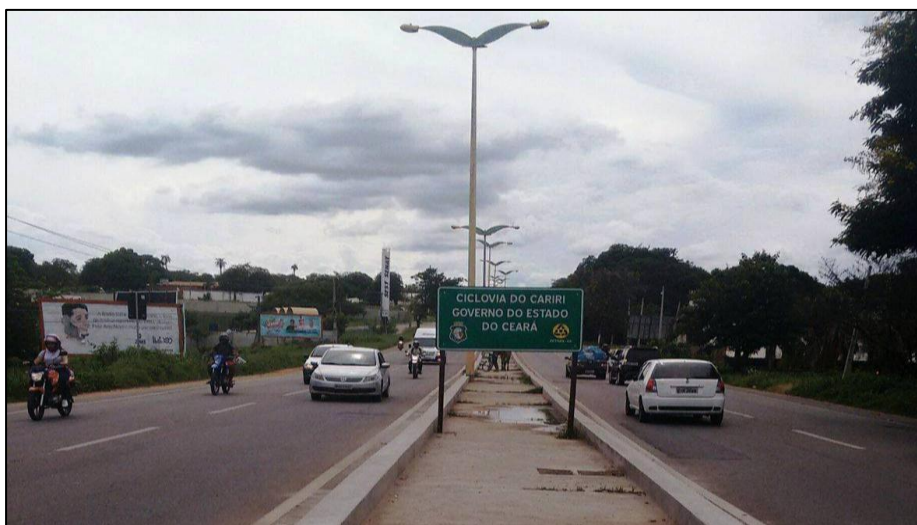
Figura 24 – Construção da “Ciclovía do Cariri” na Avenida Padre Cicero
