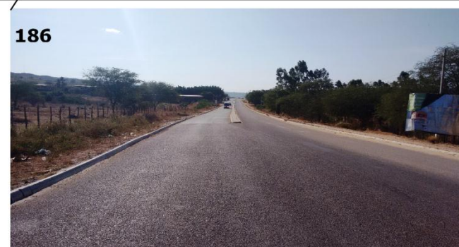
Urbanização da saída jardim Duplicação/CE- 060 Jardim
