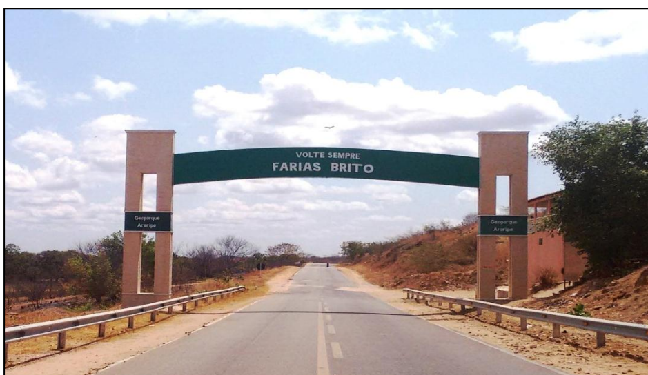
Figura 18 - Pórtico de Farias Brito
