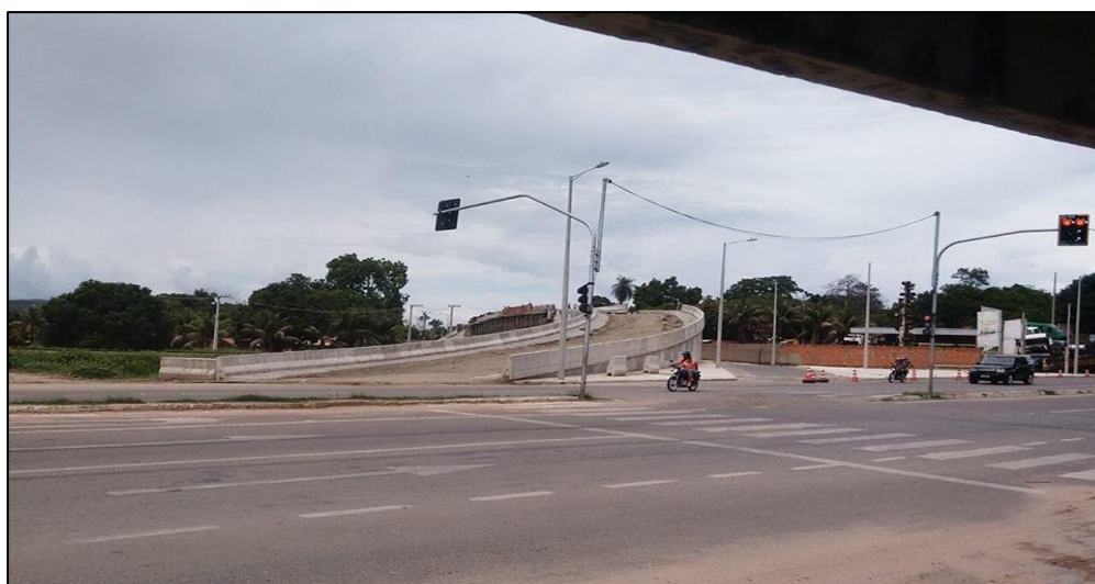
Figura 23 - Parte da Obra Avenida do Contorno (trecho 3)
