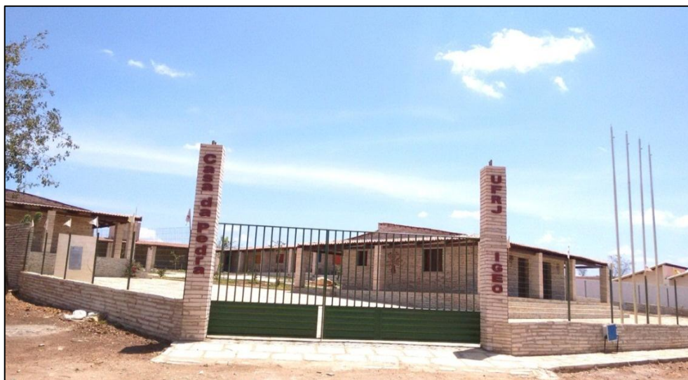
Figura 13 - Casa de Pedra da UFRJ em Santana do Cariri
