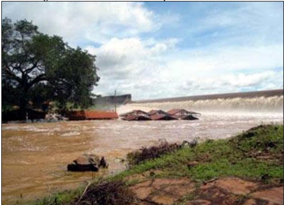
Figura 19 - Transbordamento do Açude Mesa de Pedra em 2009
