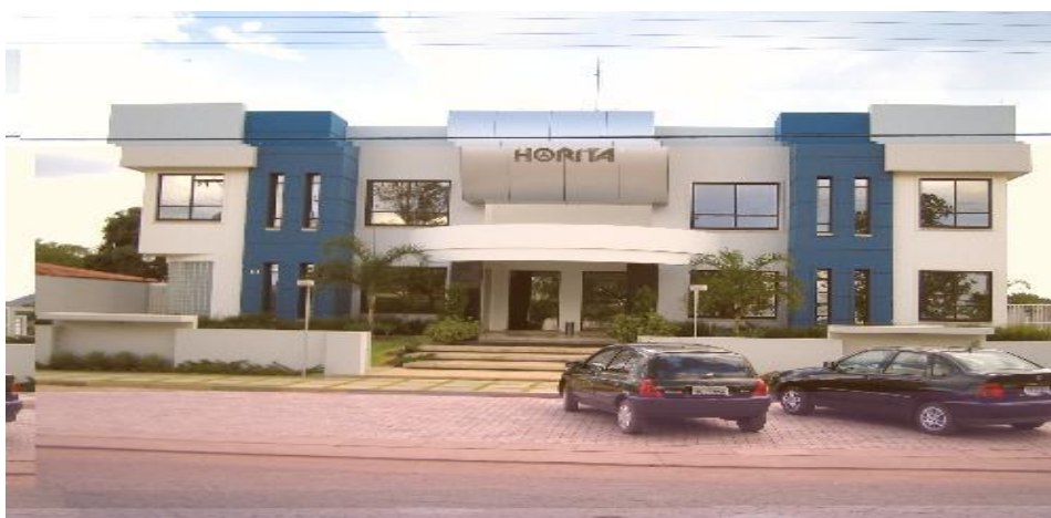
Figura 39 – Escritório central das fazendas do grupo Horita. Barreiras/BA.
