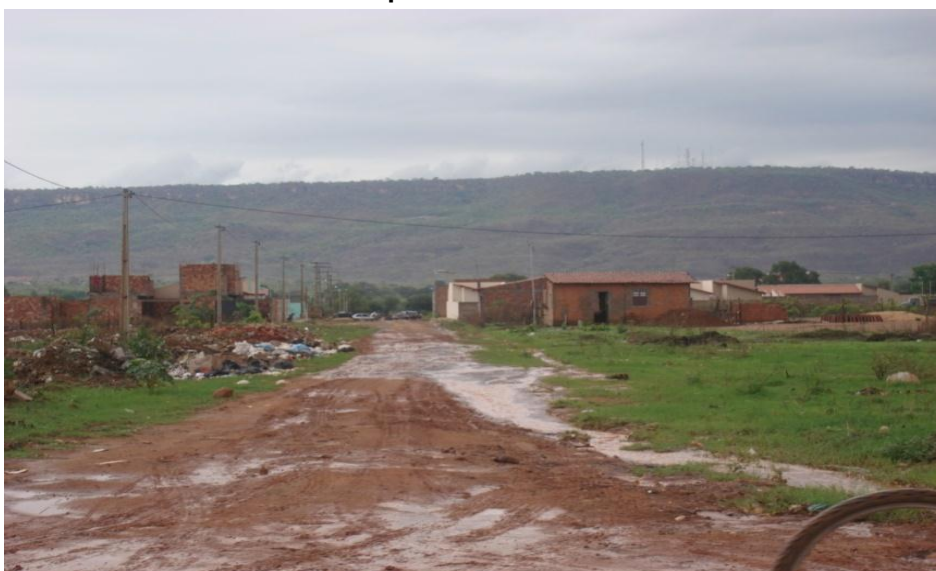
Figura 119 – Condições precárias no bairro Santa Luzia: sem saneamento, sem calçamento, com lixo exposto. Barreiras/BA
