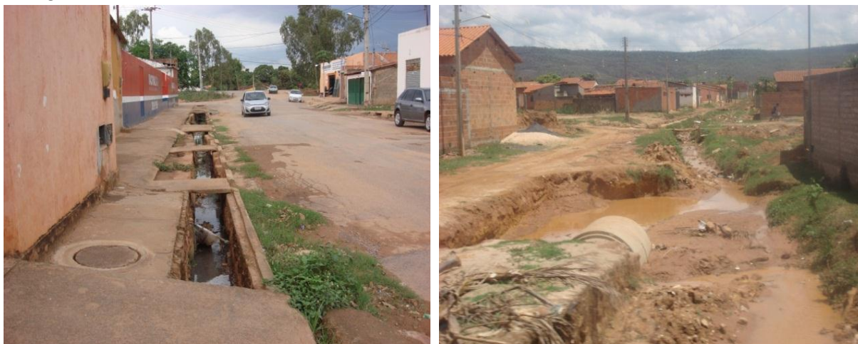
Figura 115 – Falta de saneamento básico no bairro Cidade dos Funcionários. Barreiras/BA
