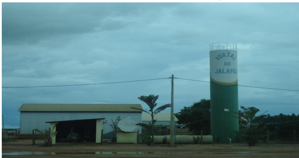
Figura 50 – Nova sede social da Coaceral, na Vila Portal do Jalapão. Formosa do Rio Preto/BA
