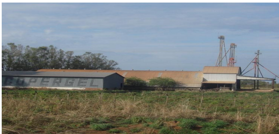
Figura 47 – Antigas instalações da extinta Copergel. Luís Eduardo Magalhães/BA
