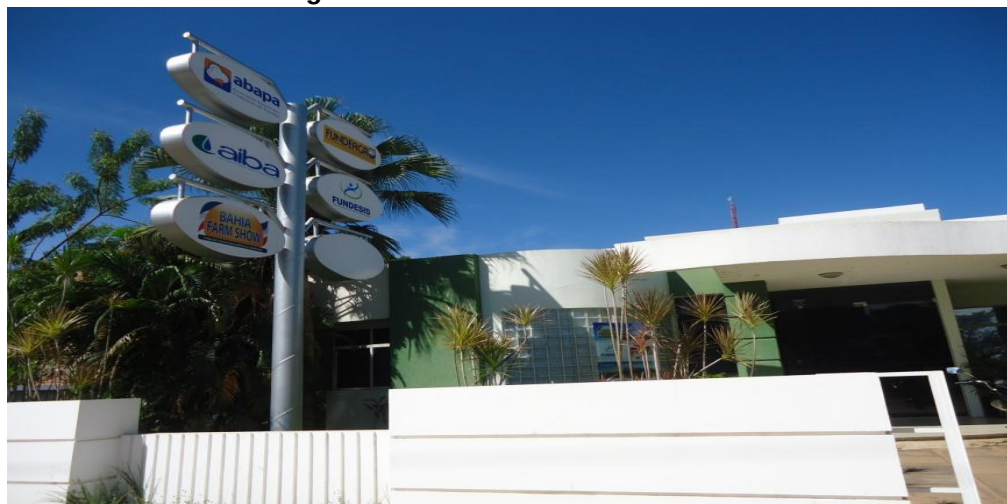
Figura 52 - Sede da AIBA. Barreiras/BA
