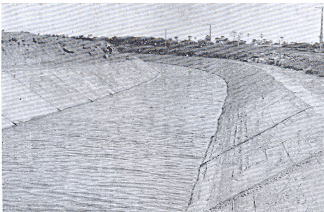
Figura 6: Canal de irrigação principal
