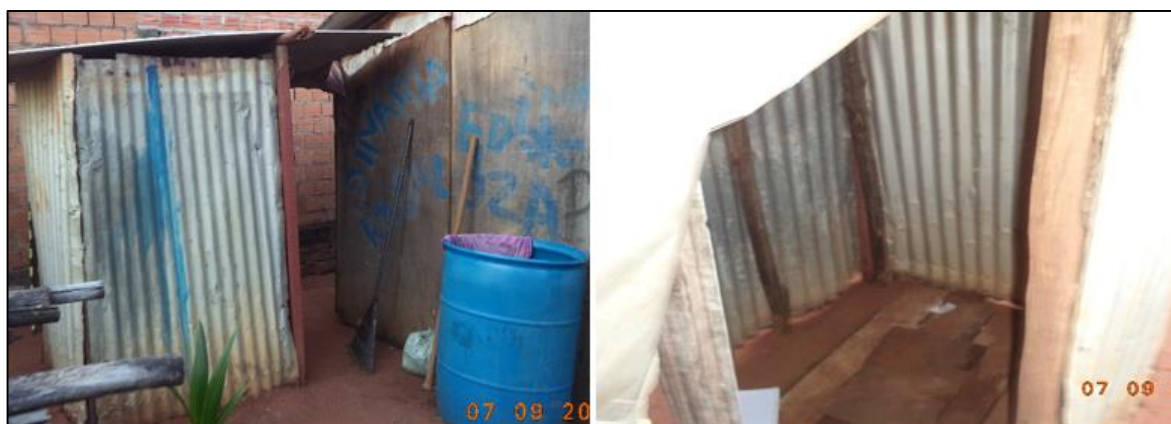
Figura 16 – Vala para depósito de excremento no aglomerado subnormal Monte Sinai – Araguaína – TO/2015
