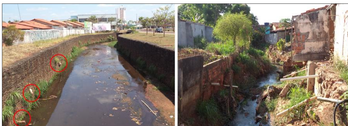
Figura 15 - Esgoto sanitário descartado no córrego Neblina (Centro) e no córrego Tanque (Setor Itapuã) – Araguaína – TO/2015
