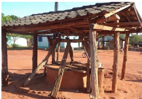
Figura 12 - Poço utilizado para provimento de água no Setor Brejão - Araguaína – TO/2015
