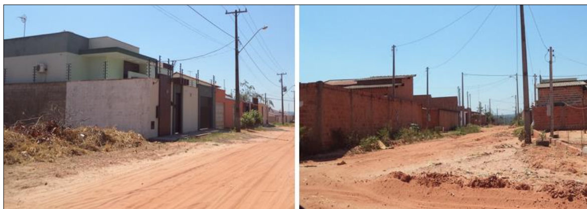
Figura 8 – Infraestrutura e padrão construtivo no aglomerado subnormal Ana Maria – Araguaína - TO/2015
