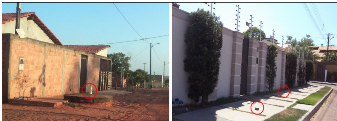
Figura 14 – Fossa rudimentar para destinação de dejetos sanitários, no aglomerado subnormal Monte Sinai e Setor Tecnorte – Araguaína – TO/2015
