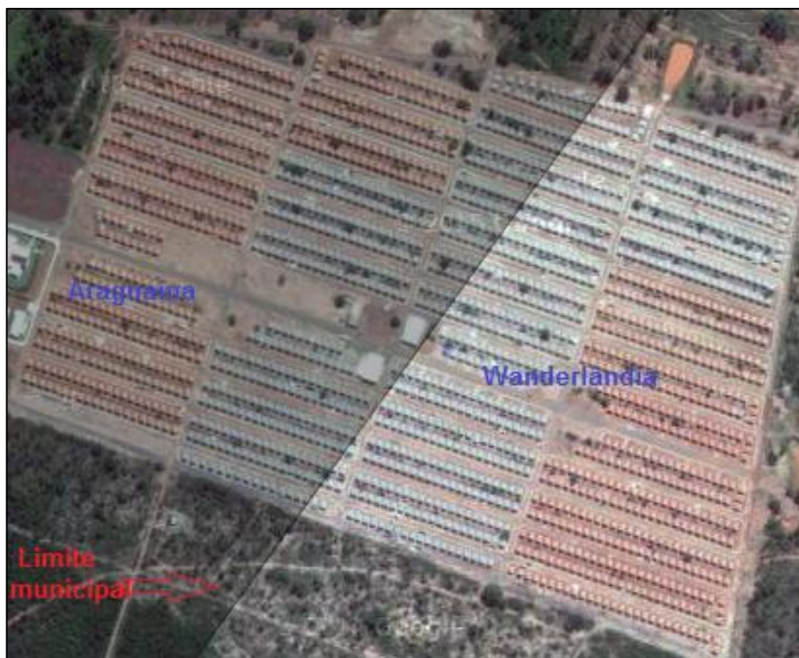
Figura 5 – Área intermunicipal do Residencial Costa Esmeralda nos municípios de Araguaína e Wanderlândia - 2015
