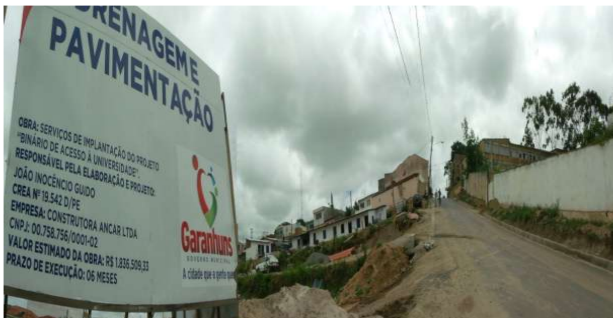
Figura 44: Obras de terraplanagem, drenagem e pavimentação, acesso a UPE. Suporte estatal para o desenvolvimento das ações educacionais
