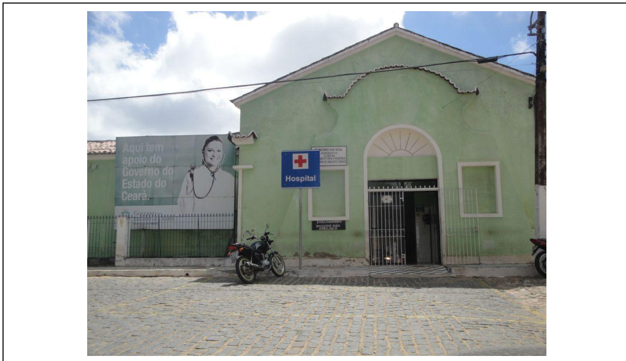
Foto 3.8 – Hospital Público da cidade de Aratuba
