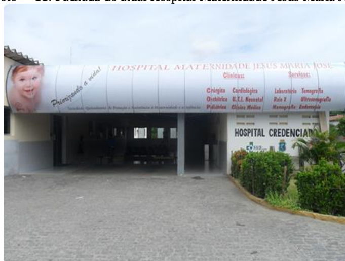
Foto 119 11: Fachada do atual Hospital Maternidade Jesus Maria José
