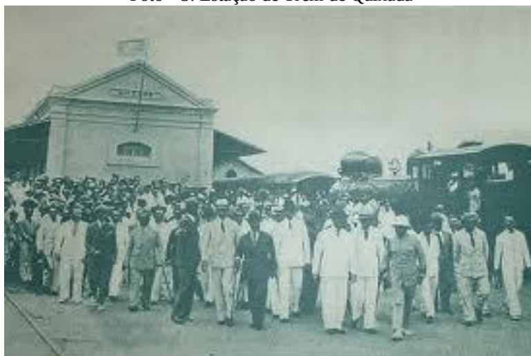
Foto 91 3: Estação de Trem de Quixadá
