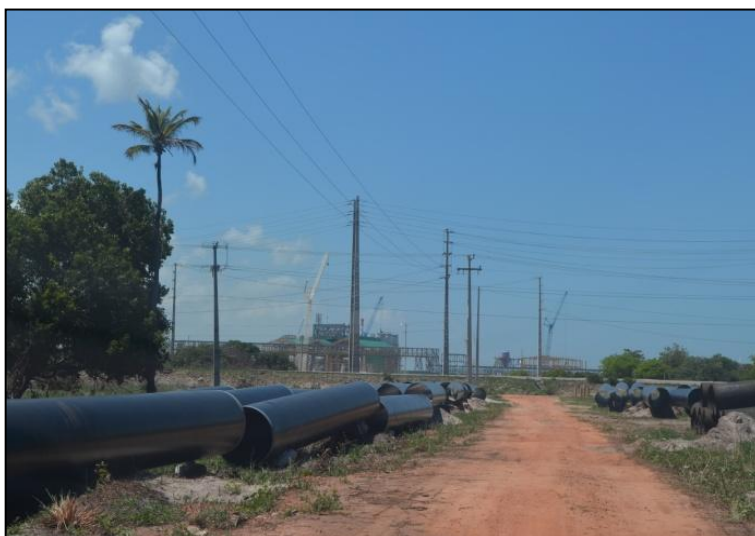
Figura 31 – Infraestrutura, em construção, para transportar água do reservatório da COGERH à CSP.
