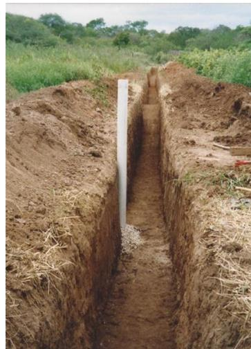
**Figuras 42 e 43:** Vala socada e acomodação de brita e cano para verificação da quantidade de água. (Localidade sub-bacia Puiú/Município Parambu).
