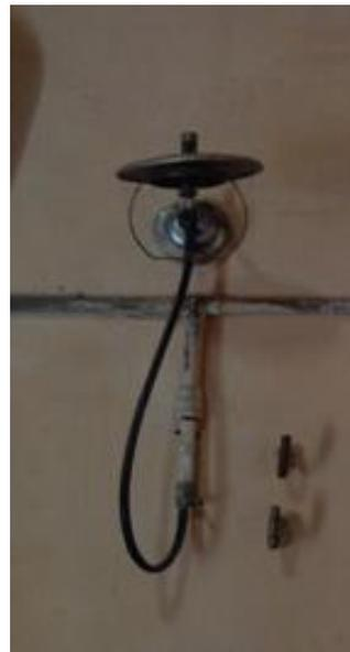
**Figuras 70 e 71:** Biogás sendo conduzido através de tubulações de PVC rígido de 3/4, embutidas e fixadas nas paredes e em cada ponto de consumo, um registro de controle que poderá ser acionado de acordo com a necessidade do *uso do gás*. (Localidade: Sítio São Gonçalo na sub-bacia Puiú).
