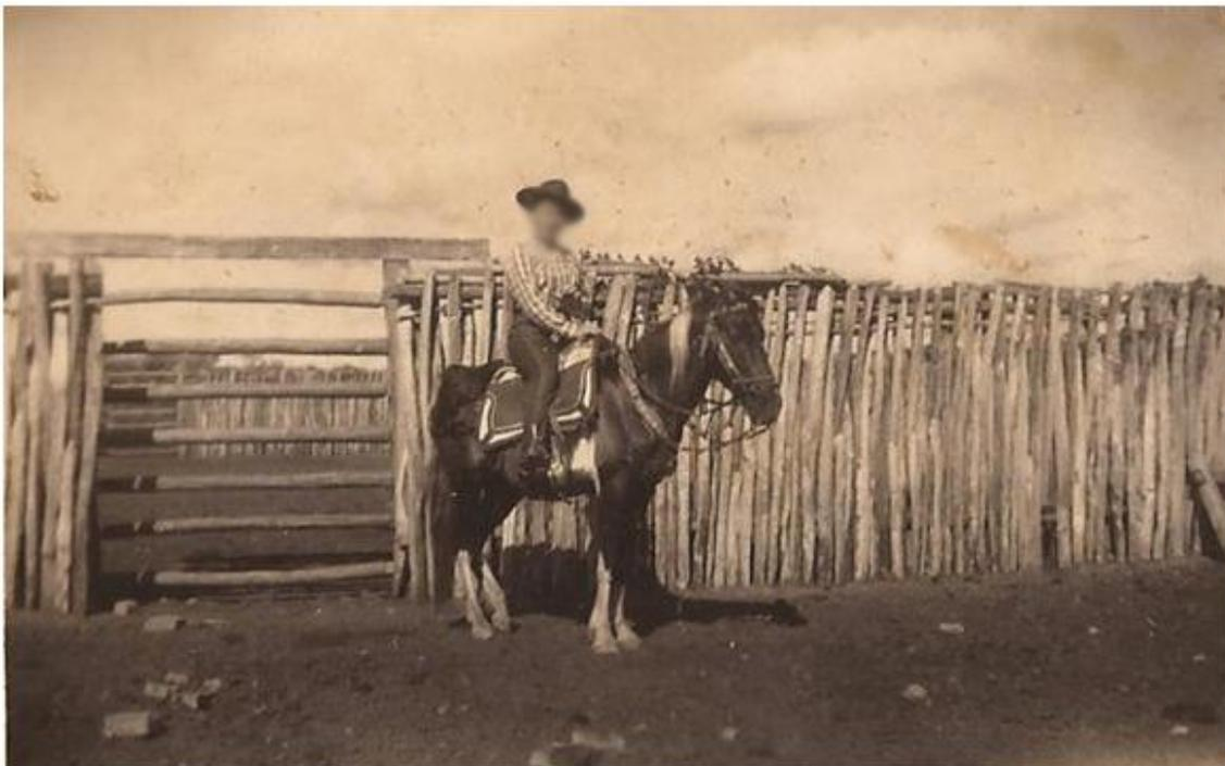
**Figura 106:** Curral para Bovinos construído com madeira de Aroeira (*Myracrodruon urundeuva*) extraída da área da sub-bacia do Jaguaribe na década de 50.
