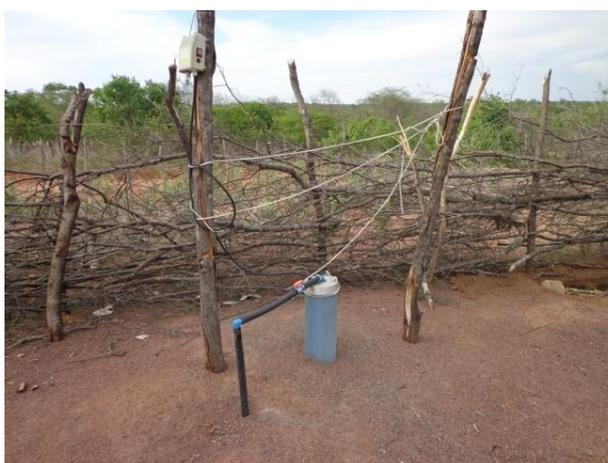
**Figuras 51 e 52:** Perfuração e instalação de poço tubular profundo em propriedade privada. (Localidade sub-bacia Puiú/Município Parambu).
