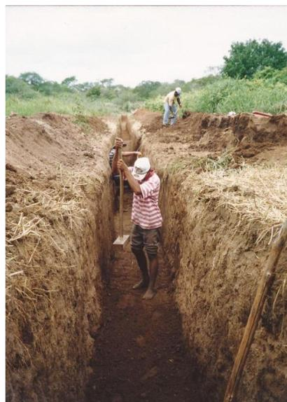
**Figuras 40 e 41:** Abertura de vala para construção da barragem subterrânea artesanal. (Localidade sub-bacia Puiú/Município Parambu).
