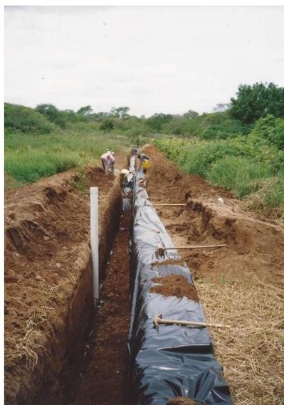
**Figuras 44 e 45:** Instalação e acomodação da lona de plástico preto. (Localidade sub-bacia Puiú/Município Parambu).
