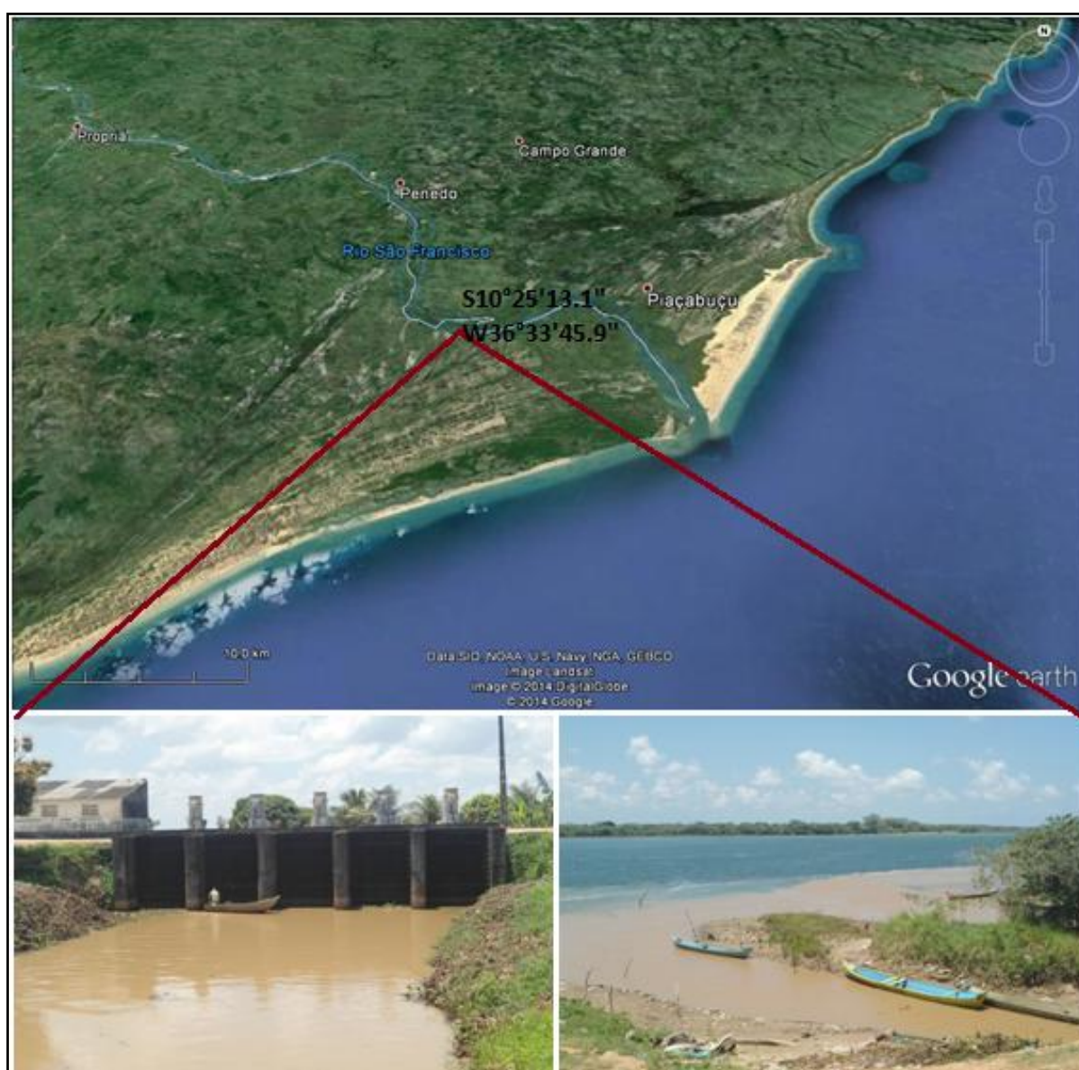
Figura 5.5: Primeiro plano acima, localização no Google Earth do canal de drenagem do perímetro irrigado de Betume em Ilha das Flores/SE. No plano abaixo, imagens do canal de drenagem com visualização da parte interna e do lançamento no leito principal do rio, respectivamente.
