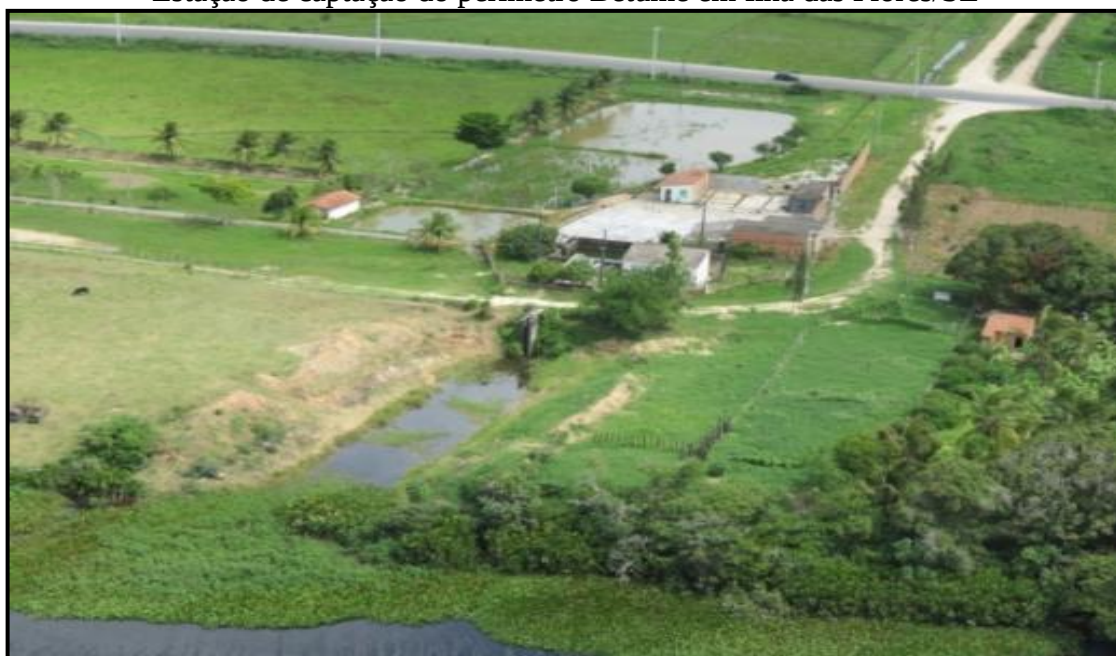
Estação de captação do perímetro Betume em Ilha das Flores/SE
