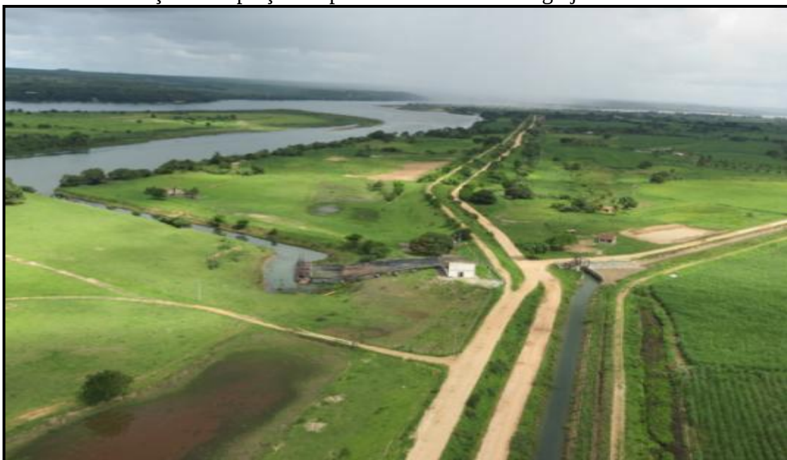
Estação de captação do perímetro Boacica em Igreja Nova /AL
