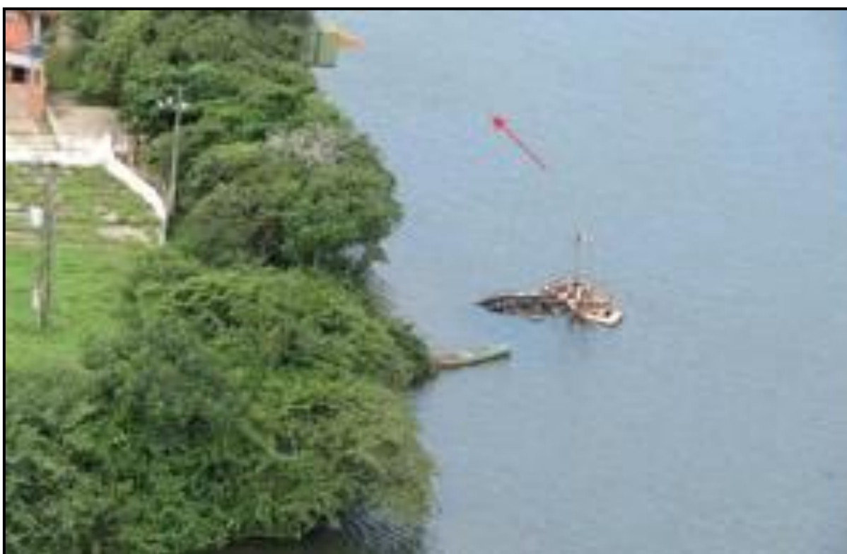
Figura 6.2. Estação de captação de Piaçabuçu/AL
