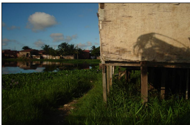
Imagem 16 - Unidade habitacional edificada em madeira, sob palafitas, alocada na faixa de preservação ambiental da Lagoa da Vila Cazumba, Fortaleza (2006).
