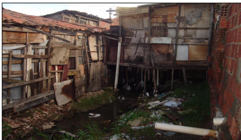
Imagem 15 - Moradias de madeira no entorno da Lagoa da Zeza e situação do esgotamento sanitário, Fortaleza (2006).
