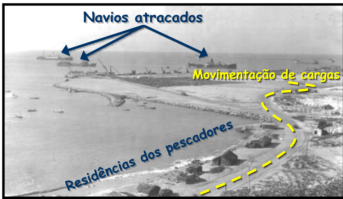
FIGURA 25 – Início da Construção do Porto do Mucuripe em 1939. Nota-se um possível aplainamento devido ao desmonte das dunas para a instalação do canteiro de obras do porto. Fonte: Arquivo Nirez ( apud FECHINE 2007), modificada por Soares (2009)
