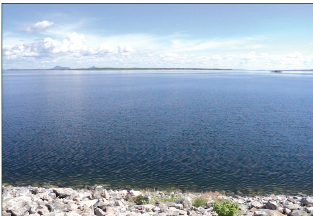
Figura 02: Açude Castanhão. Vista da barragem localizada no Município de Alto Santo. Fonte: Trabalho de Campo, 2011.
