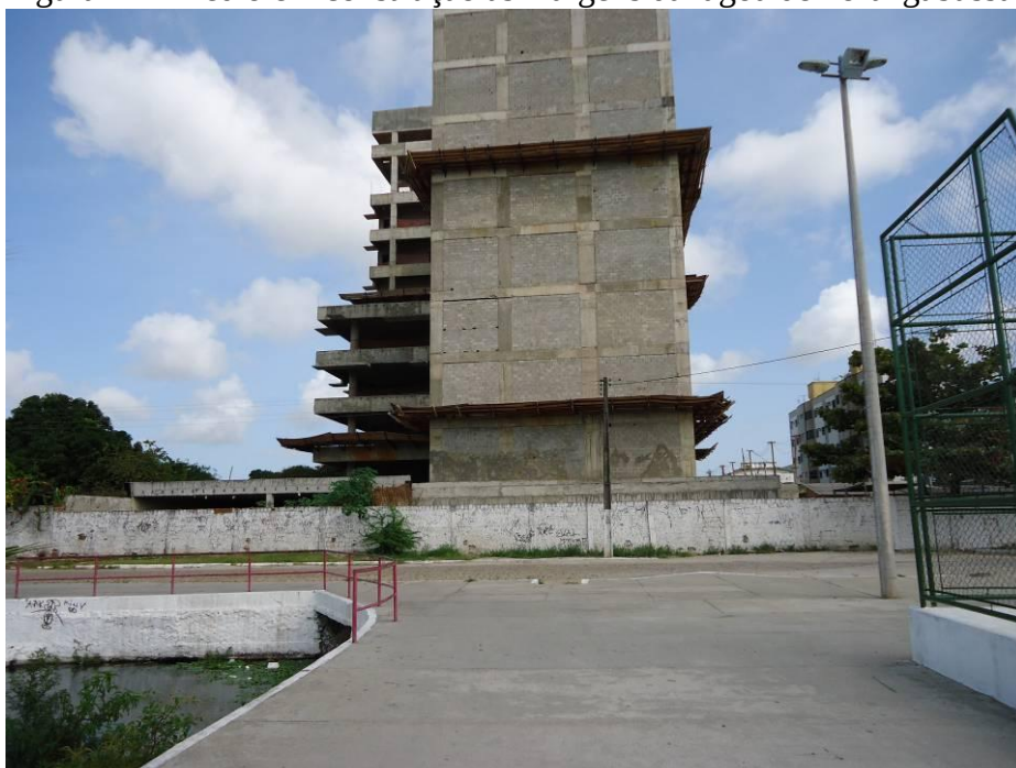
Figura 22 - Prédio em construção as margens da lagoa de Porangabussu.
