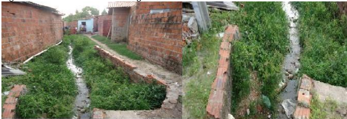
Figura 31 - Casas construídas as margens do riacho.
