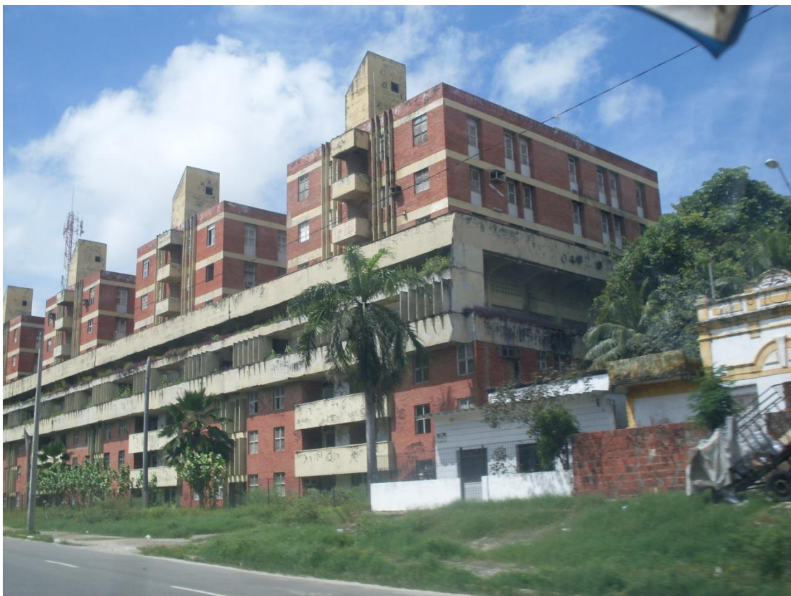
Figura 09 - Especulação Fundiária - Prédios abandonados entre Centro, Favela Moura Brasil e Av. Leste-Oeste. Fonte: PARENTE, Karlos M. N. 2011
