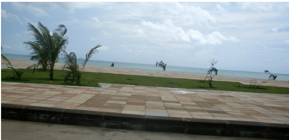
Figura 29 - Projeto Vila do Mar - Pavimentação. Bairro Cristo Redentor Fonte: PARENTE, Karlos M. N. 2011
