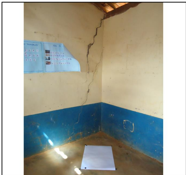
Figuras 35.3: rachaduras provenientes dos impactos de explosões da mina e demais atividade que geram vibração. (informações passadas pelo habitantes locais de Caetité, Ba)
