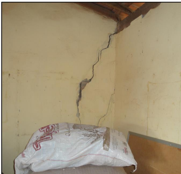
Figuras 35.3: rachaduras provenientes dos impactos de explosões da mina e demais atividade que geram vibração. (informações passadas pelo habitantes locais de Caetité, Ba)
