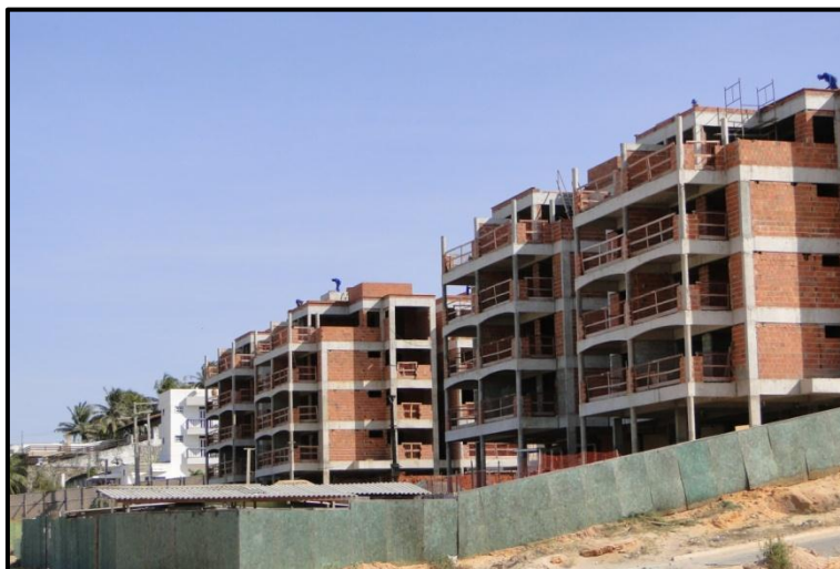
Figura 14: Condomínios de luxo em construção no Porto das Dunas. Fonte: O autor. Maio, 2011.
