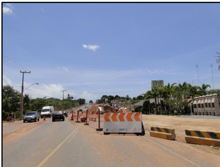
Figura 15: Obras na via CE- 025. Fonte: O autor. Maio, 2011.
