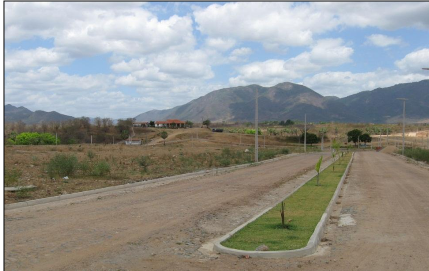
Foto 2 - Loteamento Morada dos Ventos
