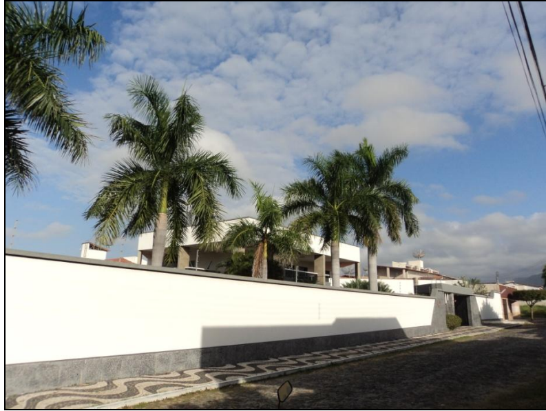
Foto 3 – Residência no Loteamento Morada dos Ventos
