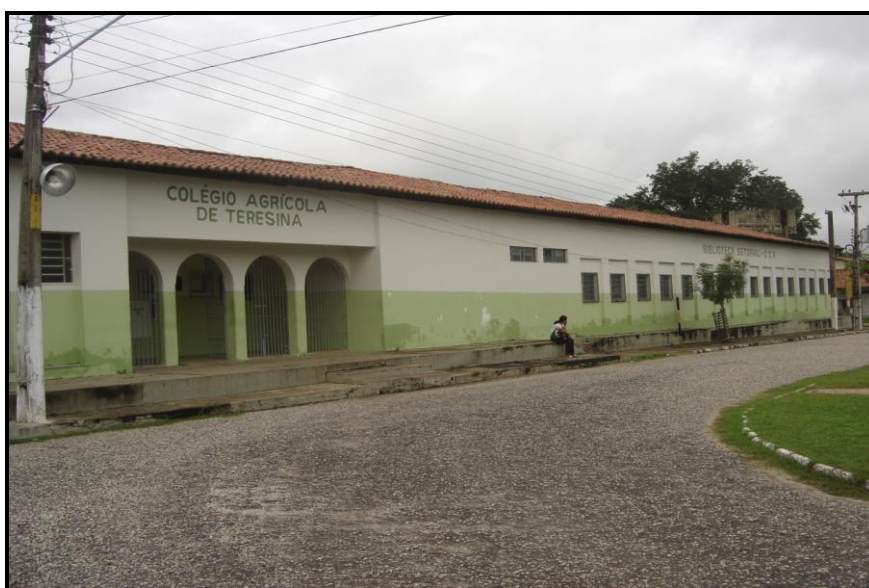
Foto 16. Fachada do prédio principal do CAT, no Campus da Socopo – UFPI. Fonte: Acervo Pessoal de Márcio Iglésias A. Silva.
