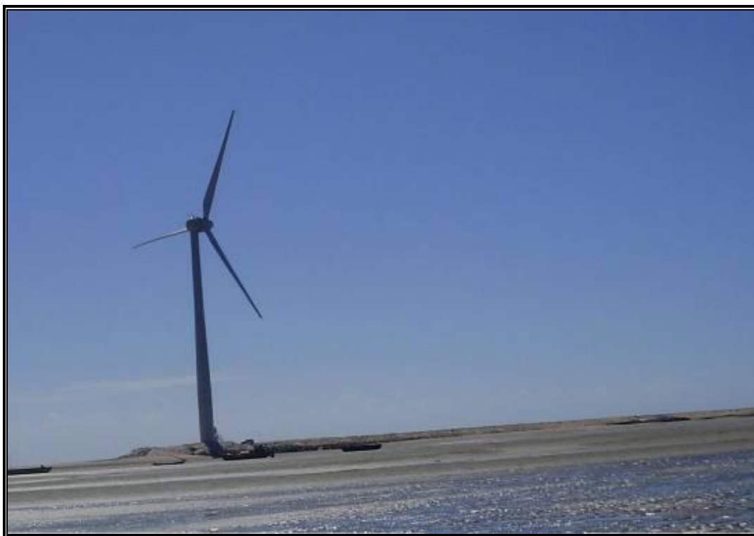
FIGURA 27 – Molhe Construído para a Fixação de Aerogeradores na Praia do Espraiado - Acaraú Foto: Oliveira (2010)
