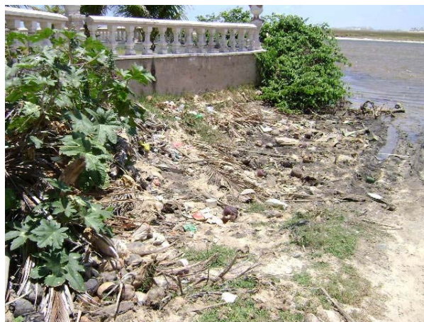
Figura 20: Lixo as margens do Rio Catú.
