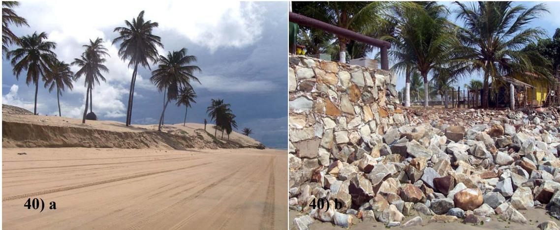
Figura 40: (a) Erosão no campo de dunas; (b) restaurante localizado no local teve seu muro destruído pelas ressacas no mês de janeiro de 2006.
