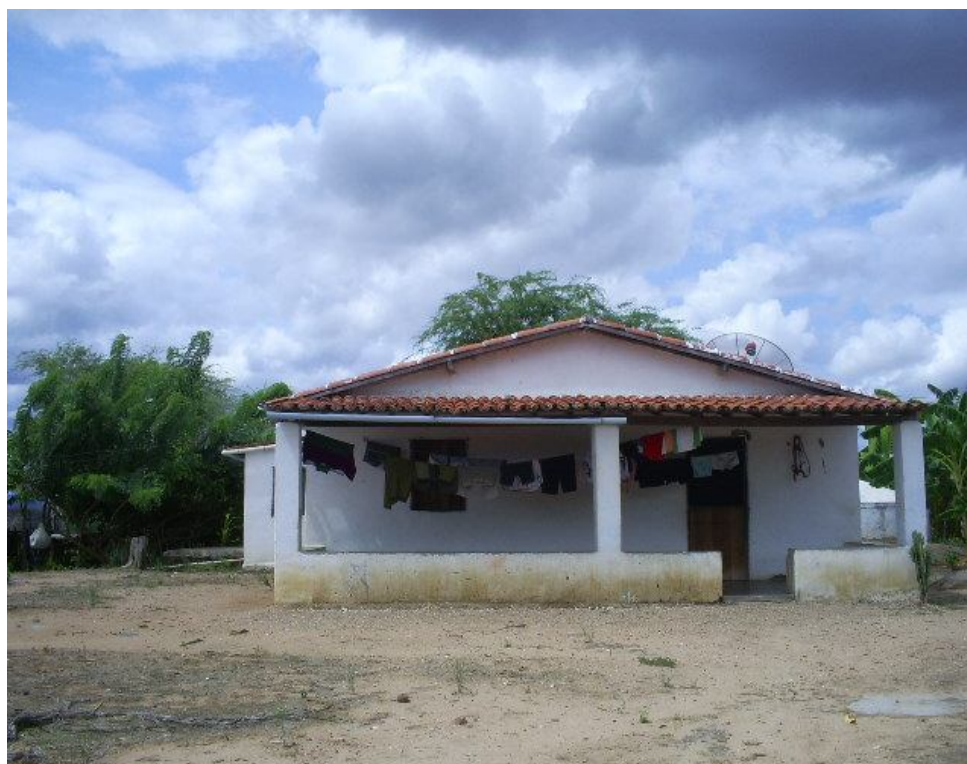
Figura 18 – Casa de alvenaria
