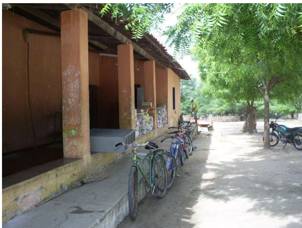
Figura 13 – Escola do assentamento
