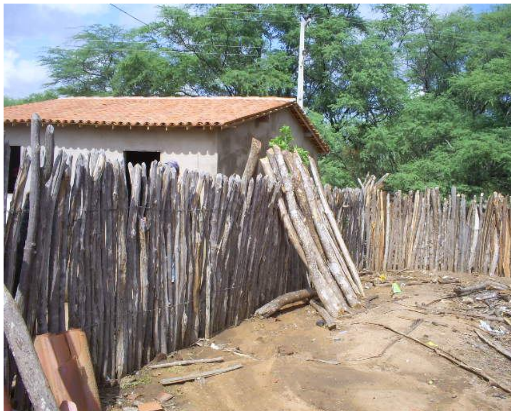
Figura 17 – Construção da casa de sementes
