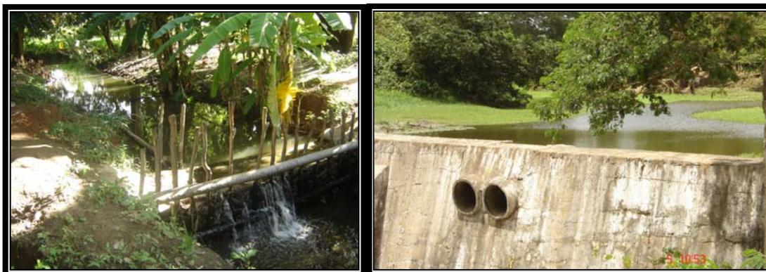
**Figura 40:** Barragens no meio rural de Maranguape: a) (esquerda) Barragem de sacos de areia no Rch Sapupara; b) (direita) Barragem de concreto no Rch da Tangueira
