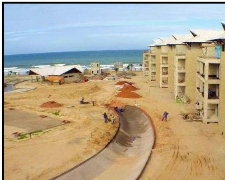
Figura 27: Execução do lago artificial
