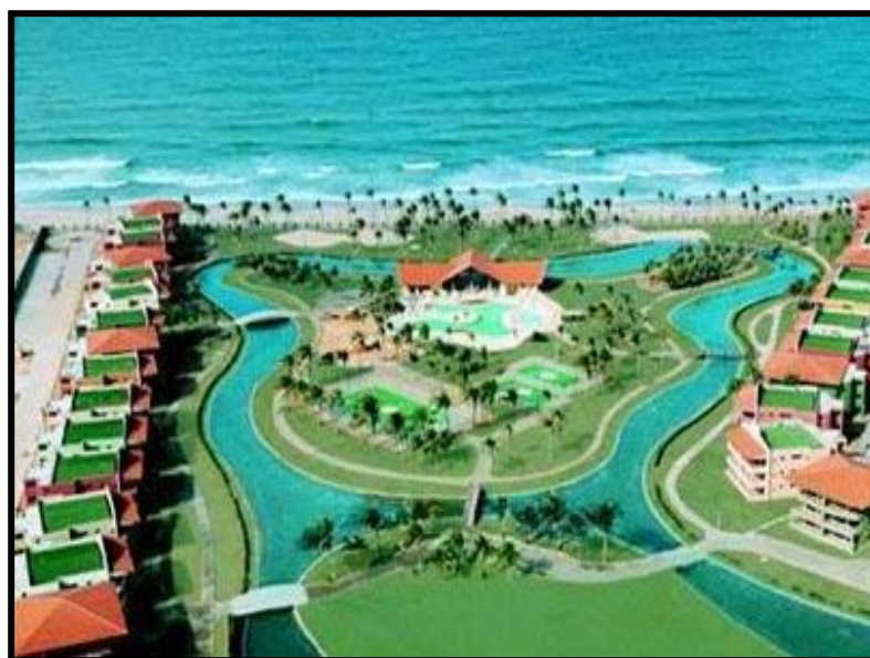
Figura 21: Vista Aérea do Aquaville Resort Fonte: www.aquavilleresort.com.br Acesso em 21/12/2008
