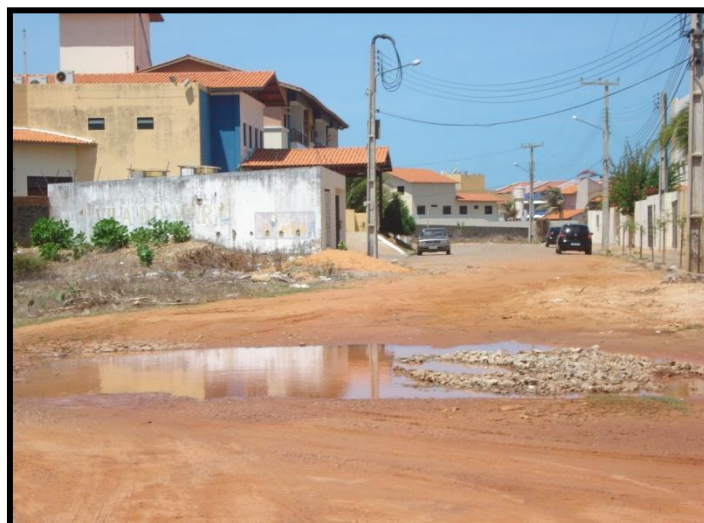
Figura 16: Rua sem pavimentação no Porto das Dunas Fonte: Sampaio, Camila F. (Janeiro 2009)
