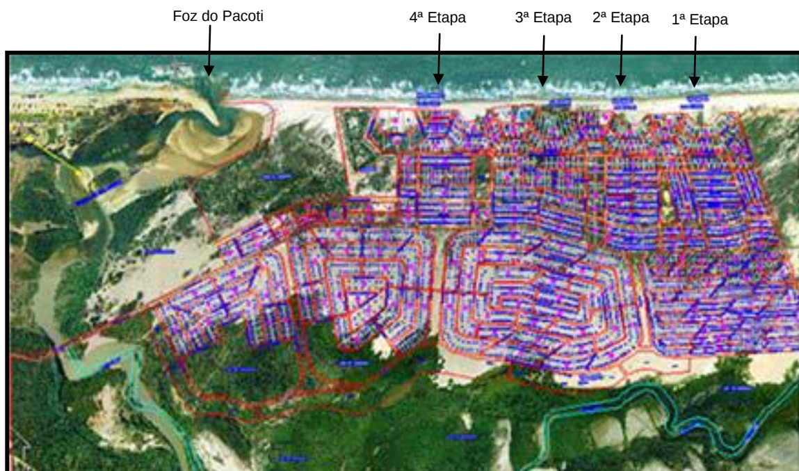
Figura 12: Foto aérea do Porto das Dunas sob traçado urbano do loteamento (PDDU-2000) Fonte: Montenegro Júnior, 2004.
