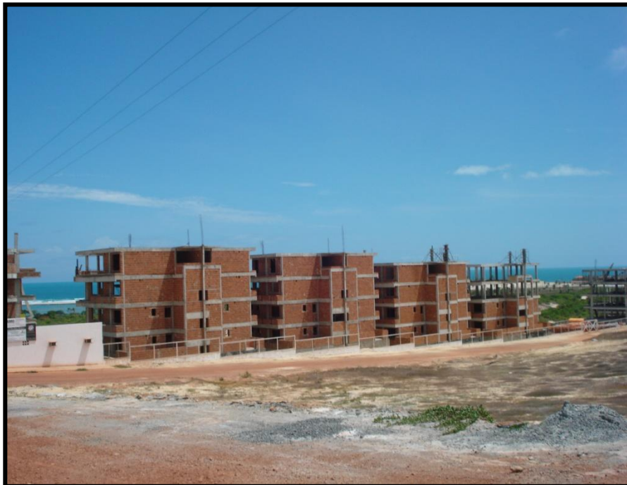
Figura 47: Avanço das obras do Dunnas Flat Fonte: Sampaio F. Camila (março de 2008)
