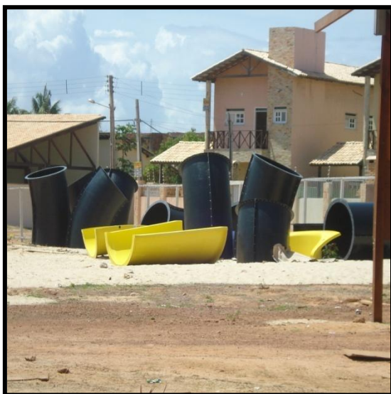
Figura 34: Material para montagem dos toboáguas Fonte: Sampaio, Camila (Jan, 2009)
