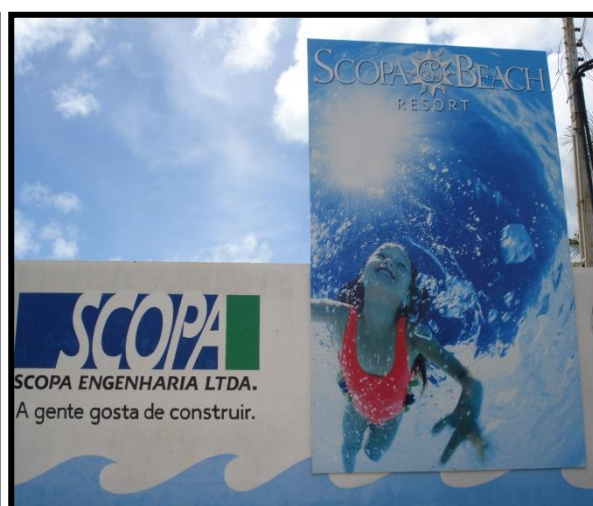
Figura 53: Local da obra do Scopa Beach Resort Fonte: Sampaio F. Camila, 2008
