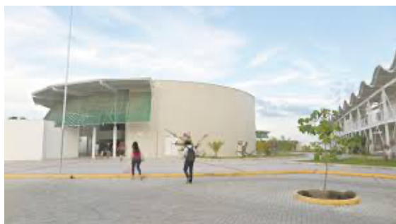
Figura 3 – Bloco H: Auditório principal
