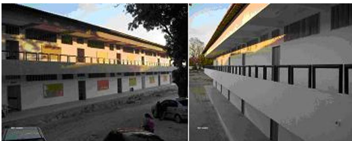
Figura 3 – Fotografias dos Blocos de Salas de Aula
