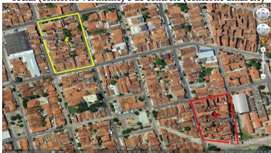
Figura 53 - Visão aérea dos agregados da Vila Ellery, áreas de intervenção eco-bio-social (contorno vermelho) e de controle (contorno amarelo)
