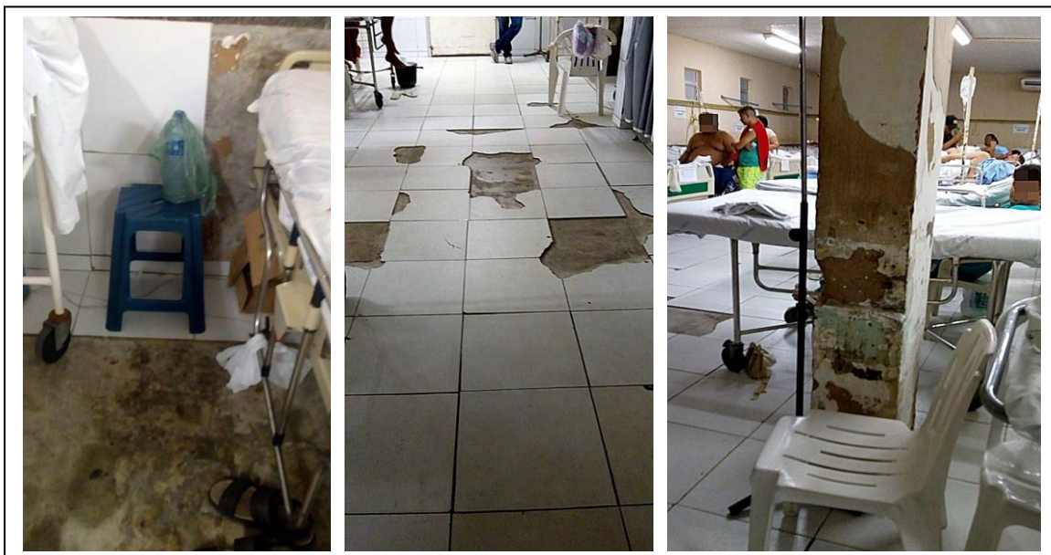
Figura 1 - Salão da emergência.
