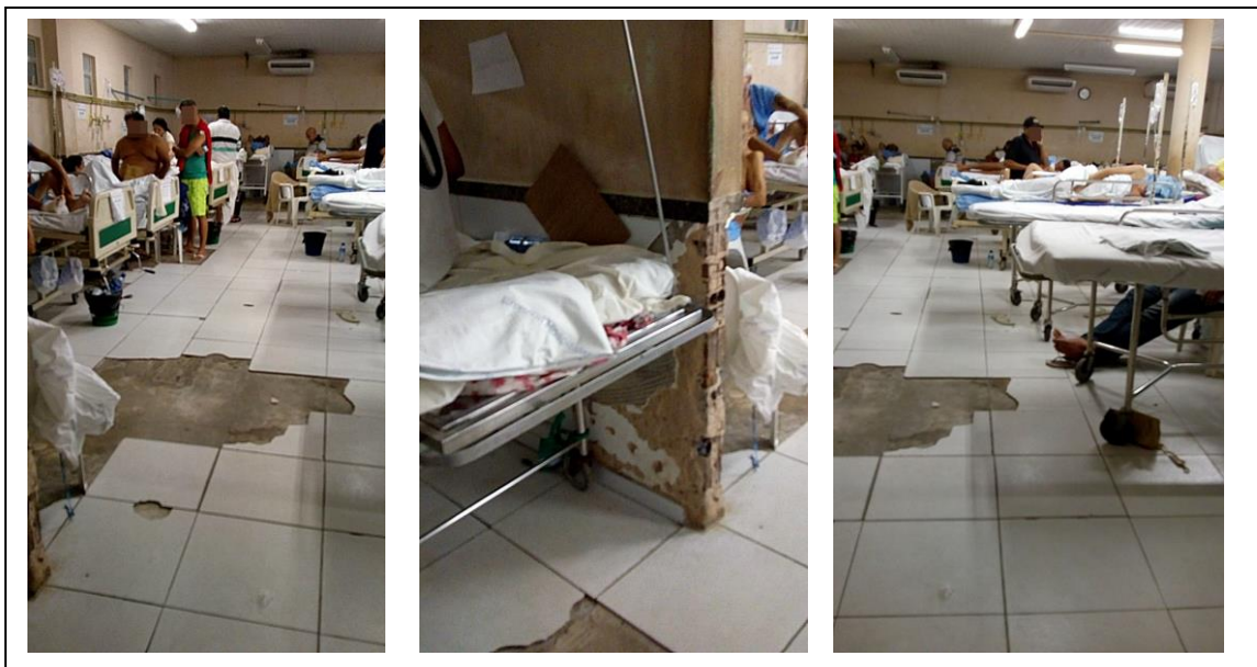
Figura 2 - Salão da emergência.
