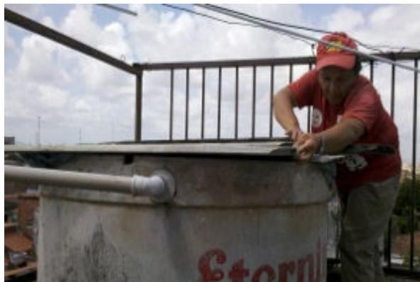
**Figura 14 - Agregado Messejana: Ação de vedação de caixa d'água**
