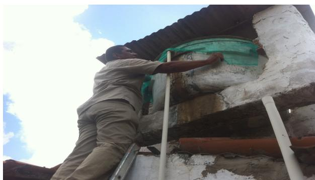
**Figura 7 - Agregado Parreão: Ação vedação de caixas d'água**
