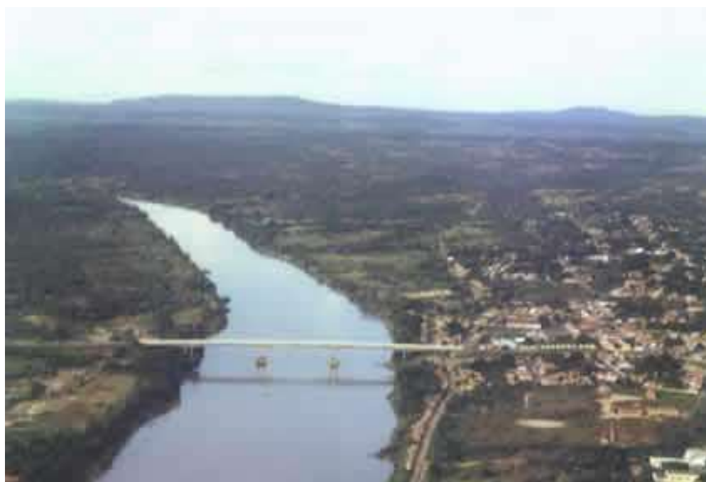
Figura 4- Ponte sobre o Rio Parnaíba que liga os estados do Maranhão e Piauí e as cidades Barão de Grajaú a Floriano - Piauí.
