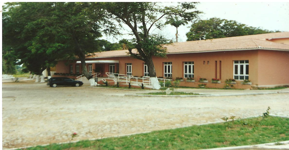
Figura 03 - Hospital Mental de Messejana – HSMM. Fortaleza-CE Fonte: HSMM, 2007
