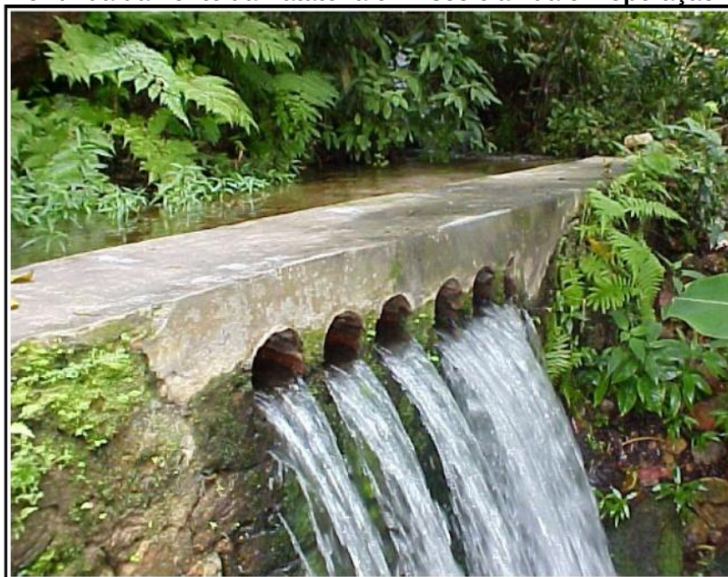
Figura 17 - Telhas d'água (instrumento para medição de vazão) utilizada na cidade do Crato e oriunda da Fonte da Batateira em 1855 e ainda em operação
