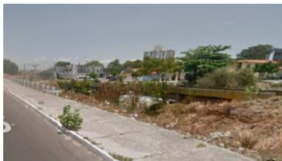
VIADUTO RAUL BARBOSA - 2013 (1)
