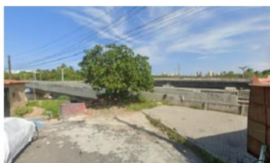
VIADUTO RAUL BARBOSA - 2022 (2)
