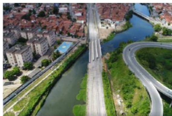
2022 - PONTE DO TUAPE
