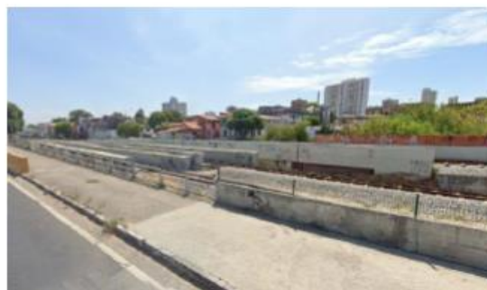
VIADUTO RAUL BARBOSA - 2022 (1)
