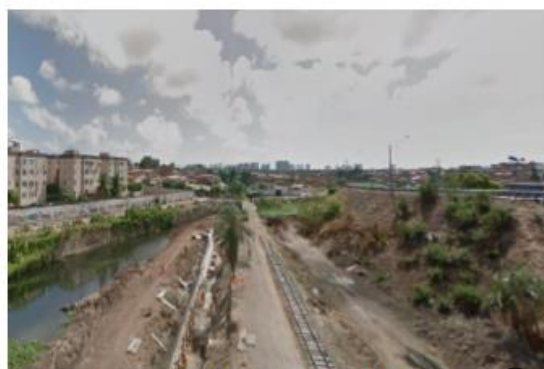
2012 - PONTE DO TUAPE
