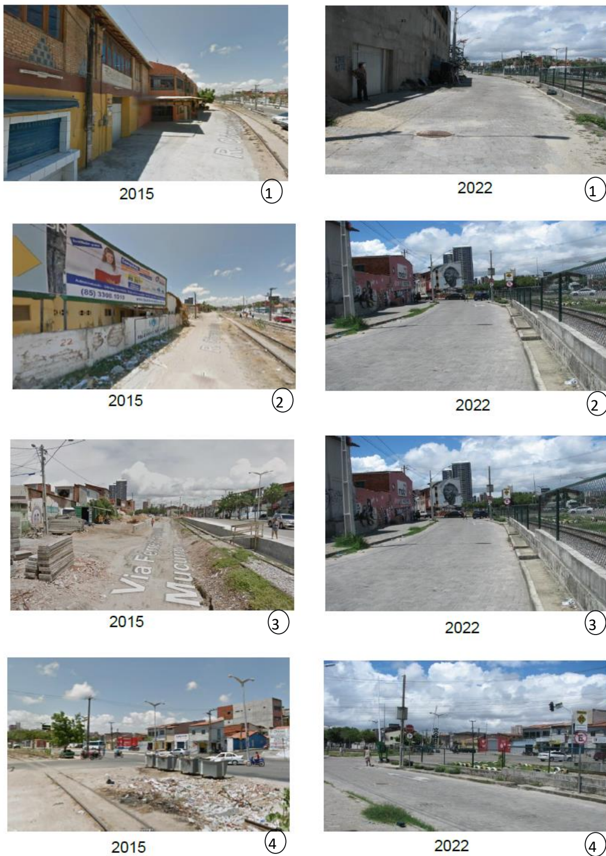
Figura 135 - Registro fotográfico da época da implantação do VLT e da situação atual
