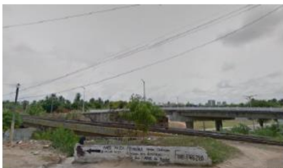
VIADUTO RAUL BARBOSA - 2013 (2)
