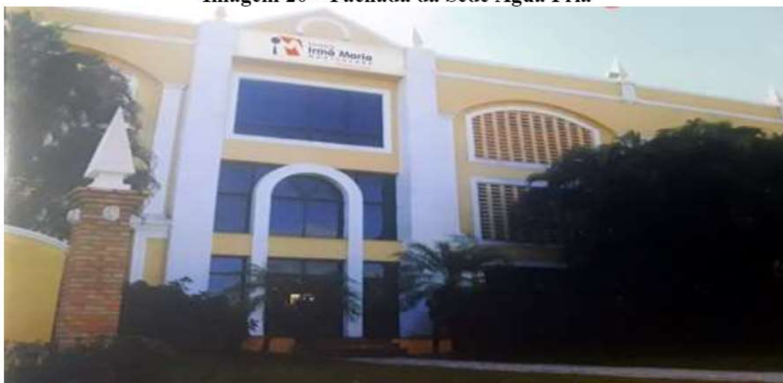
Imagem 20 – Fachada da Sede Água Fria
