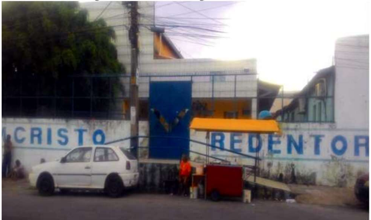
Imagem 24 – Fachada do Colégio Cristo Redentor
