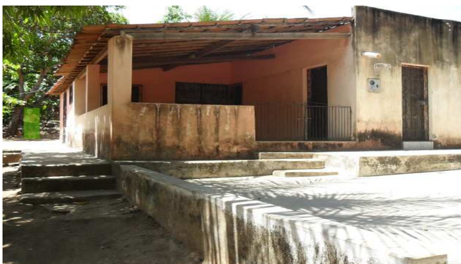
Figura 8: Vista externa do anexo
