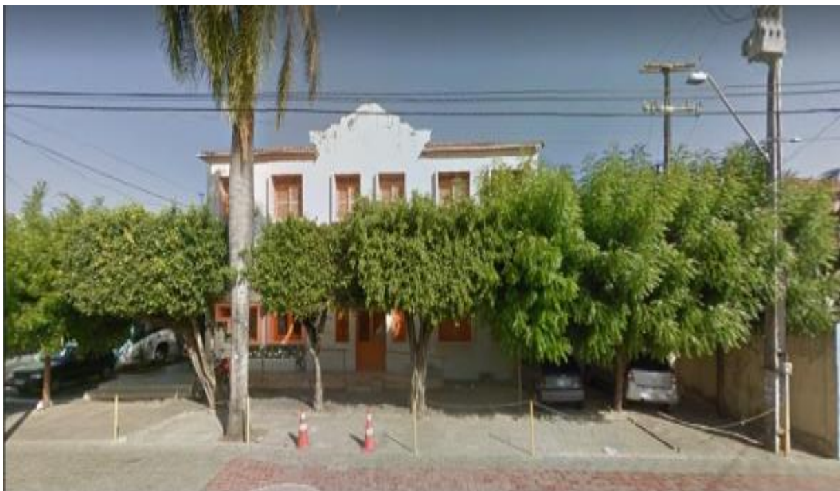
Figura 4 – Imóvel pertencente à Congregação das Irmãs de Caridade, onde funcionou a Escola de Enfermagem São Vicente de Paulo (dias atuais)
