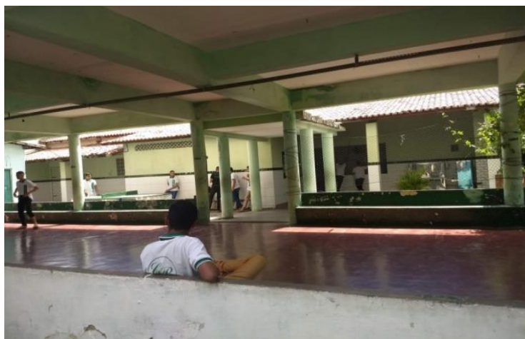
Figura 4 - Pátio interno E1
