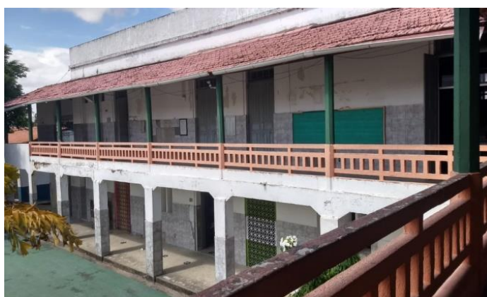
Figura 14 - Pavimento superior e inferior E3
