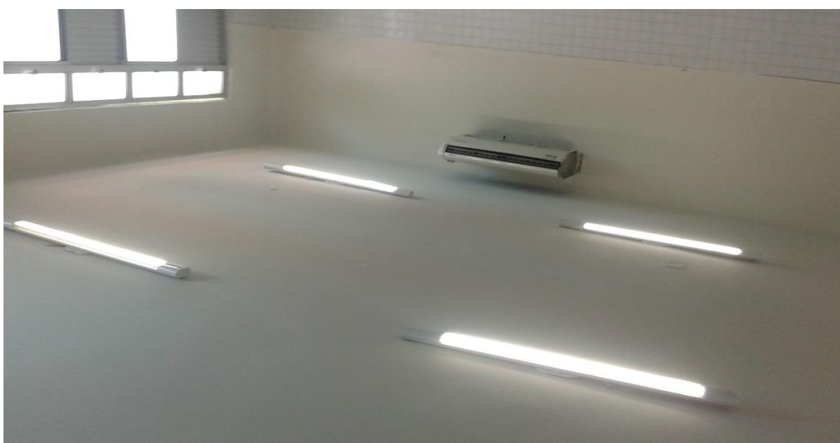
Foto 15 – Sala de Aula - Área Superior
