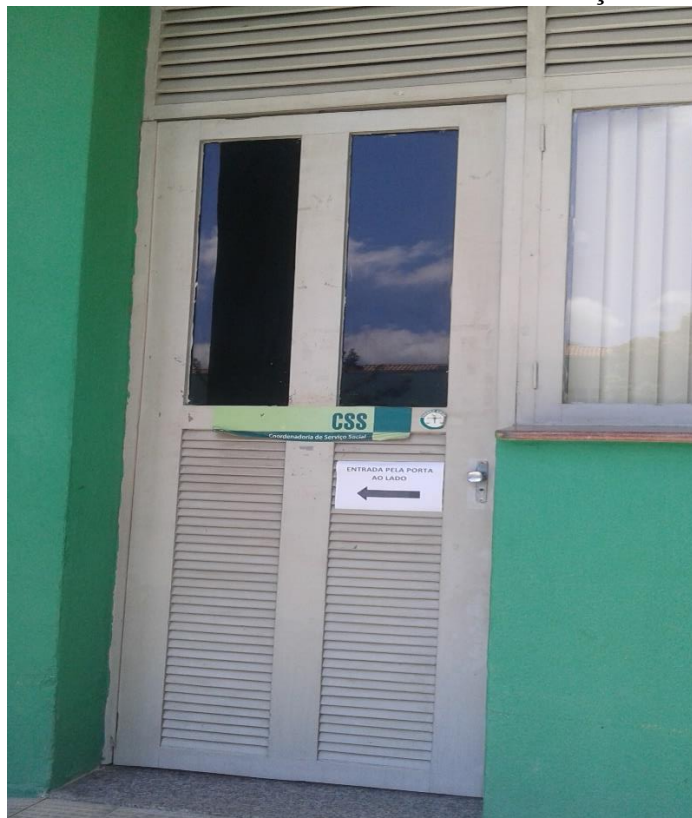
Foto 26 – Entrada da Controladoria de Serviço Social
