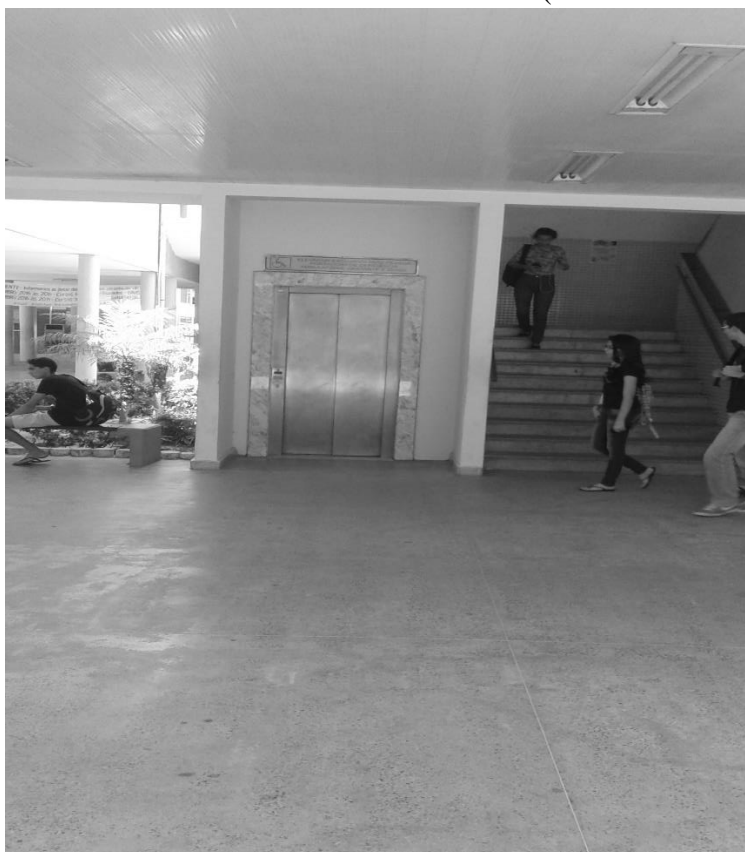
Foto 23 – Pátio do Bloco Central – Acesso (Elevador e Escada)
