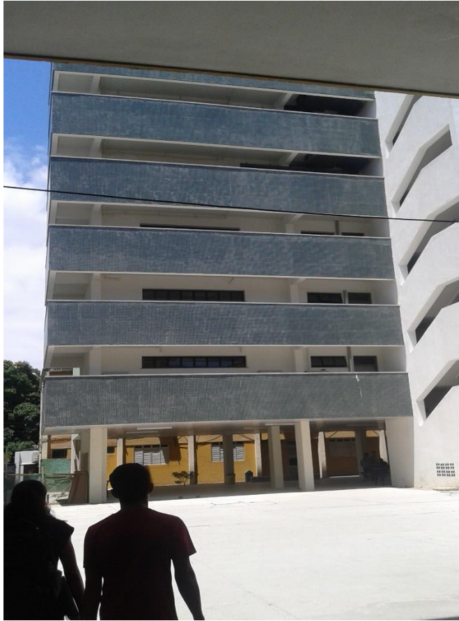
Foto 19 – Bloco de Engenharia Civil
