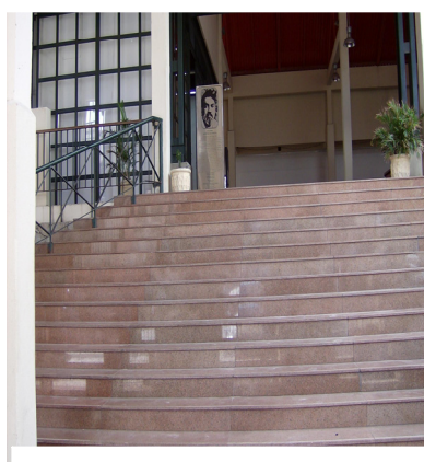
FIGURA VIII – Escadarias do CRP
