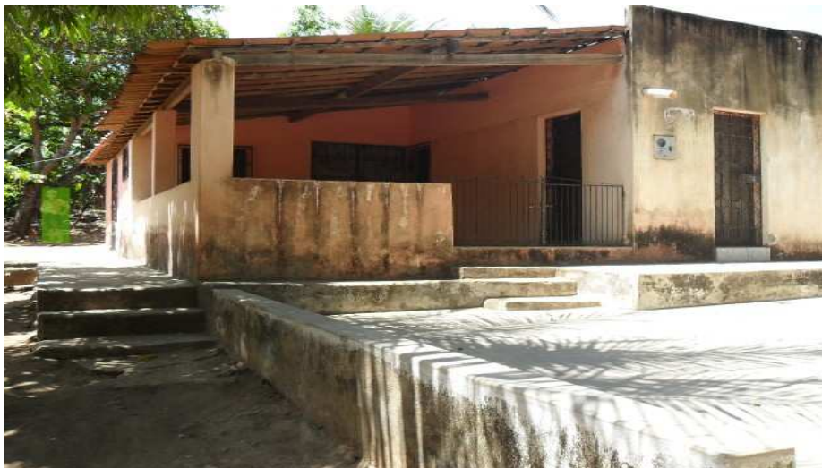
Figura 8: Vista externa do anexo
