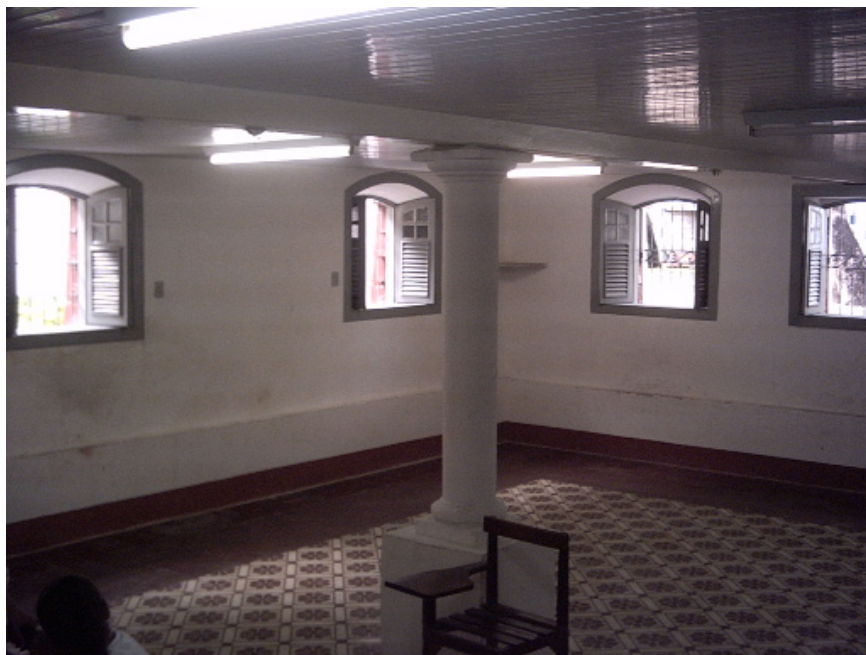
Sala de porão
