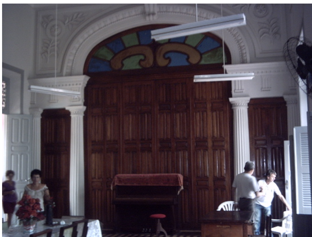
Sala de professores com belo painel de madeira que, quando retirado, unia duas salas para formar o salão nobre.
