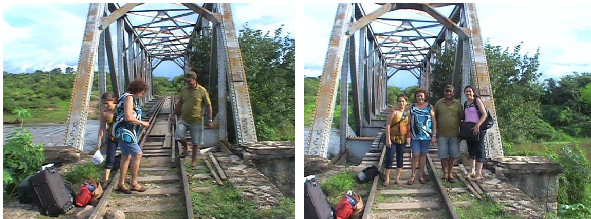
Figura 4: Ponte que serve como estrada alternativa nos períodos de chuva
