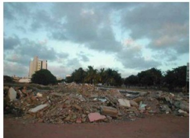
Figura 4 – Bota-fora irregular, João Pessoa (PB) Fonte: BARBOSA, 2003.
