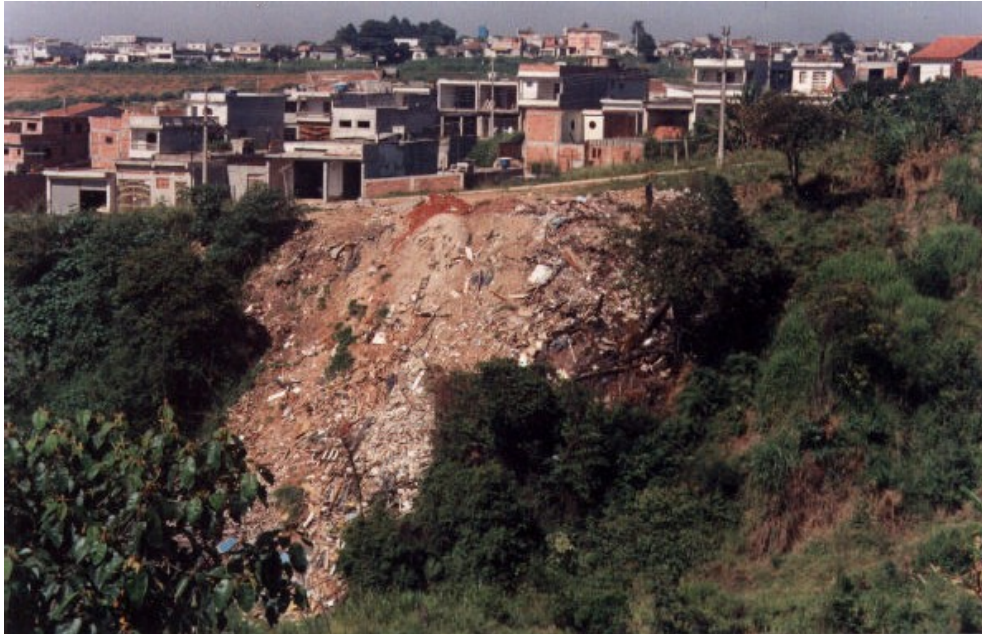
Figura 5 – Descarte irregular de resíduos de construção, São Paulo (SP) Fonte: Departamento de Limpeza Urbana, arquivos do núcleo gestor de RCD, 2002.
