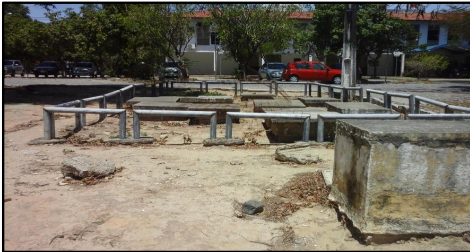
Foto 7 - Estação de tratamento de água (Itaperi)
